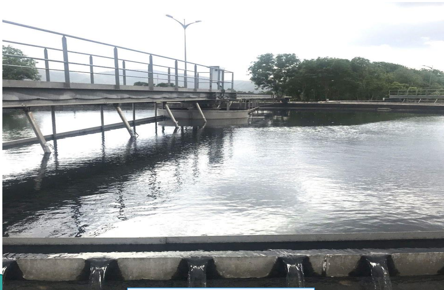
Hình ảnh 5: Dàn gạt bùn bán cầu toàn phần
